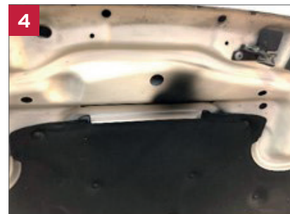
4 Rußspuren an der Motorhaube, sie entstehen wo die Hitzeschutzbleche enden
