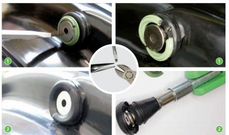
Jetzt kann das Ventil einfach mit dem ALLIGATOR Standardeinzieh-hebel nach Außen durch das Ventilloch gezogen werden.
